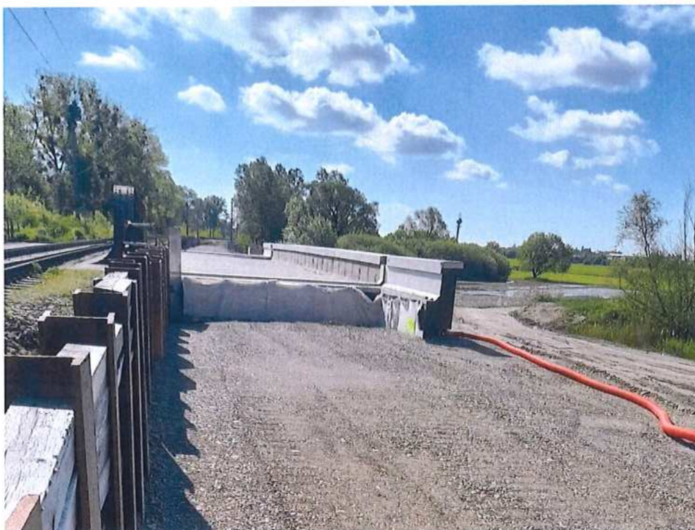
Realizácia prechodovej oblasti pri opore č. 2 – SO 12-33-01
