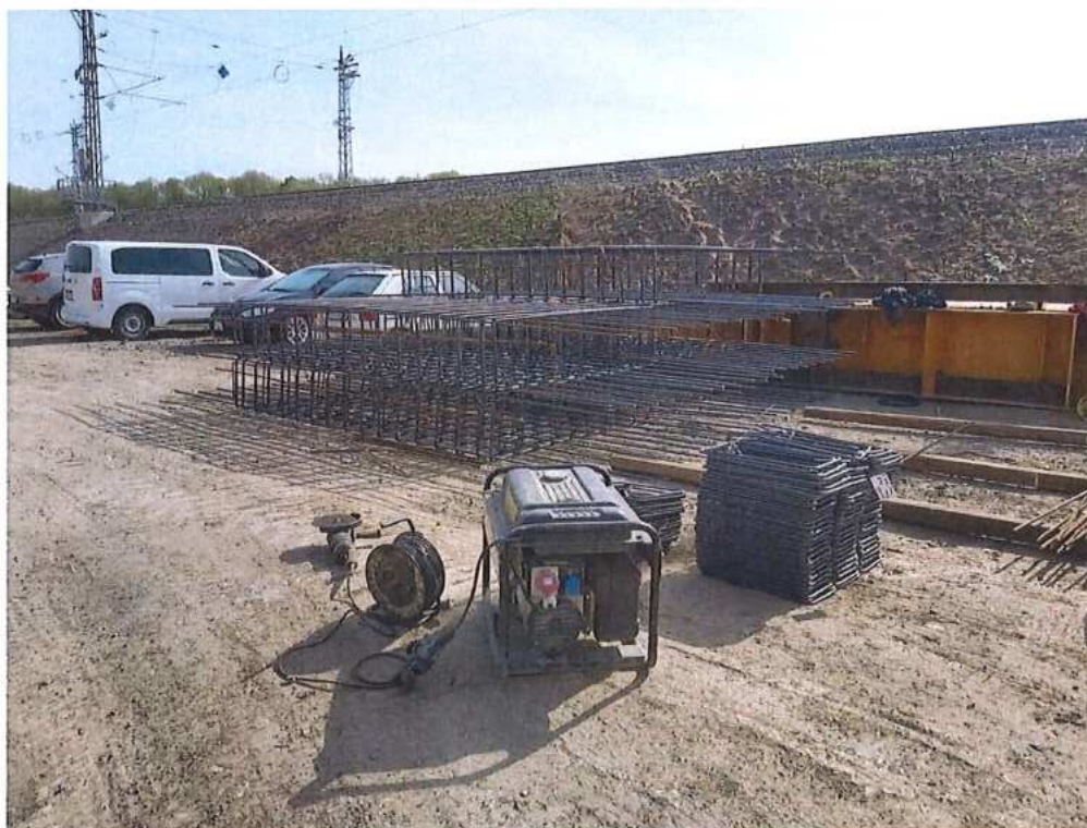
Príprava armokošov pre pätky výsuvnej dráhy – SO 12-33-04
