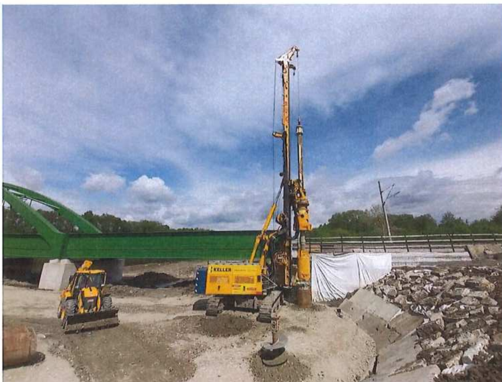
Realizácia pilót na opore č.1 SK strana – SO 12-33-04
