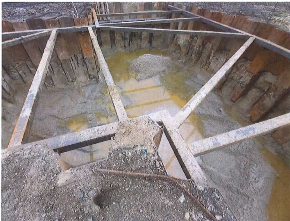
Zemné práce v zaistenom výkope v TK 1 – SO 11-33-01
