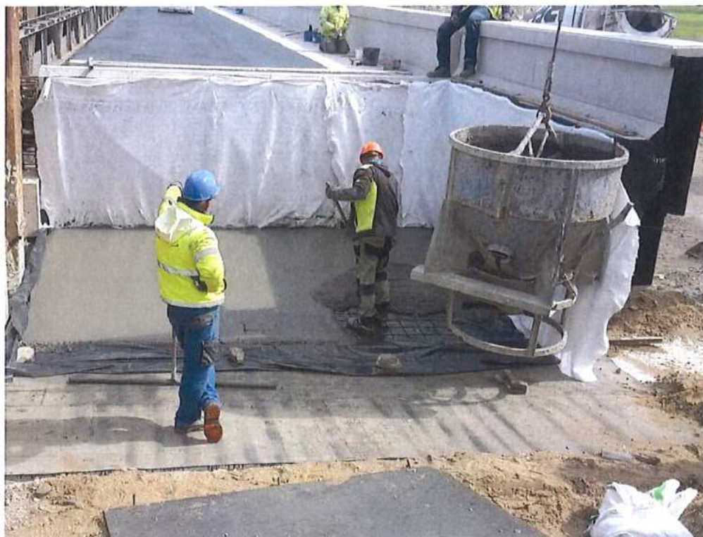
Betonáž v prechodovej oblasti opory č. 2 – SO 12-33-02
