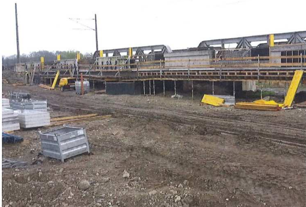
Armovanie a debnenie rímasy – SO 12-33-02
