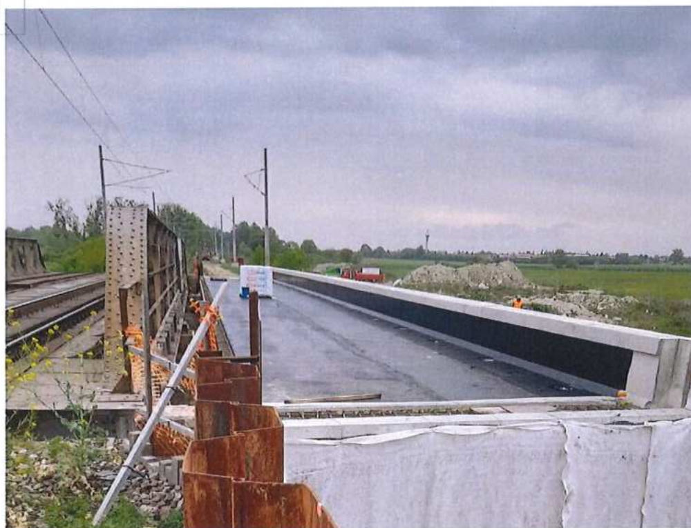
Penetračný náter mostovky – SO 12-33-02
